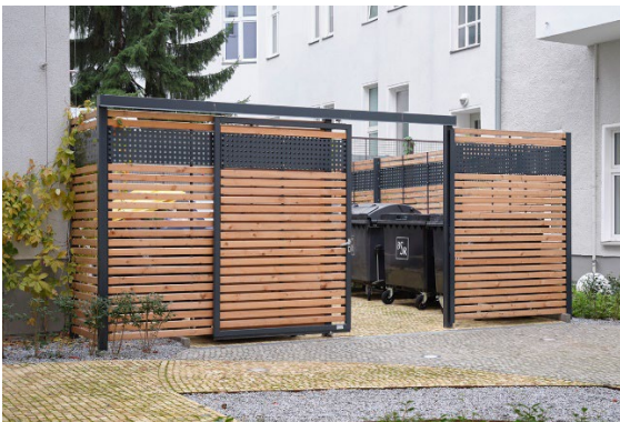
Müllplatz ohne Dach
